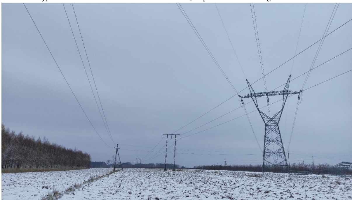
Zdjęcie nr 2. Linia 400 kV Kozienice – Ostrowiec; słup nr 181 – widok fragmentu obiektu.
