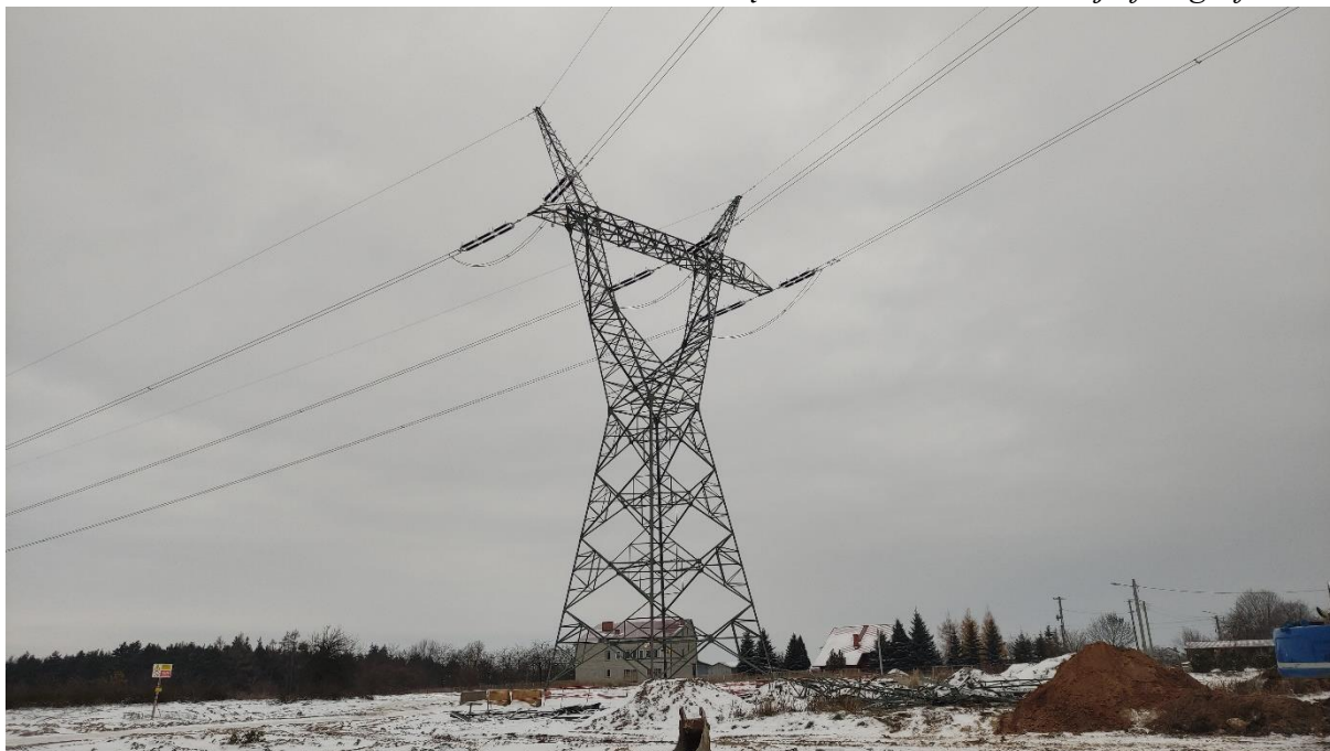
Zdjęcie nr 1. Linia 400 kV Kozienice – Ostrowiec; słup nr 182 – widok fragmentu obiektu.
