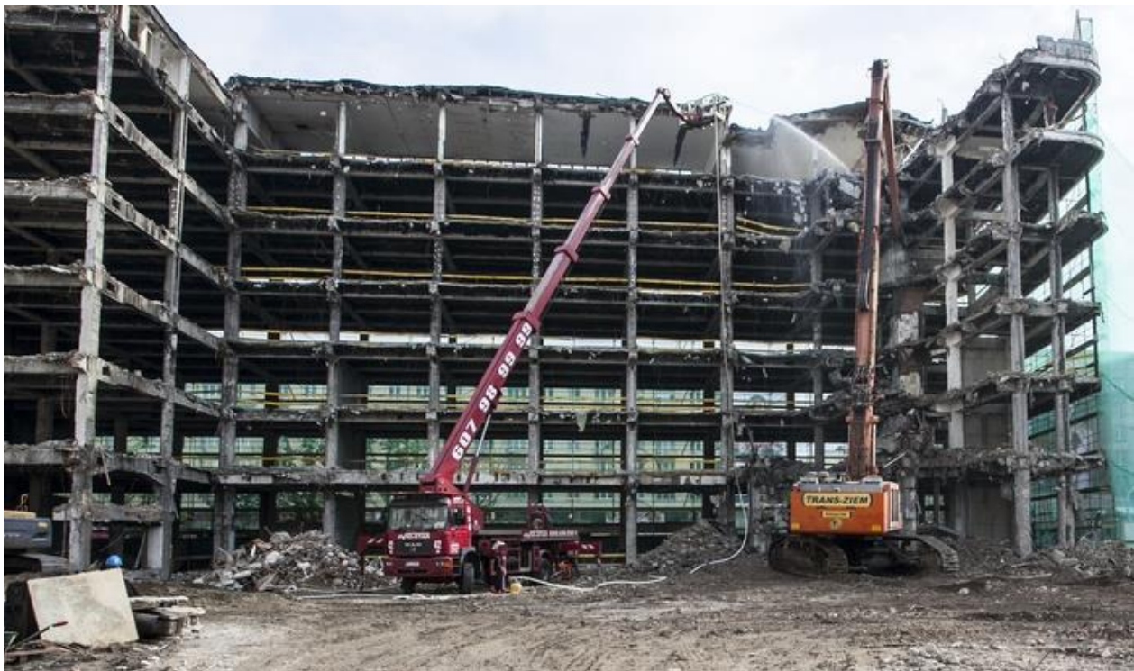
Ryc. 49. Remont „na wydmuszkę” budynku warszawskiego domu towarowego SMYK”
