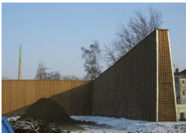
Rysunek 5 Przykładowy ekran akustyczny – ziemny ekran akustyczny z konstrukcją stalową (źródło: Ecotec Polska)
