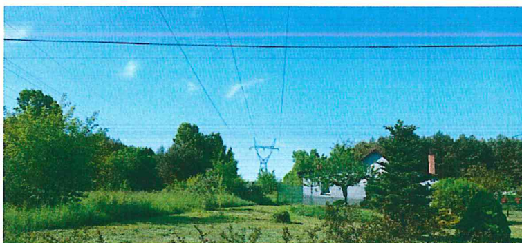
Budynek w prześle 2 – 3 linii 220 kV
